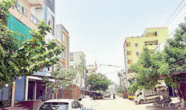
రామంతాపూర్ భగాయత్‌లో అనుమతి లేకుండా వెలినిన నిర్మాణాలు
